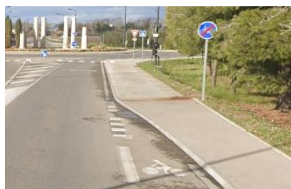
Rupture de continuité
